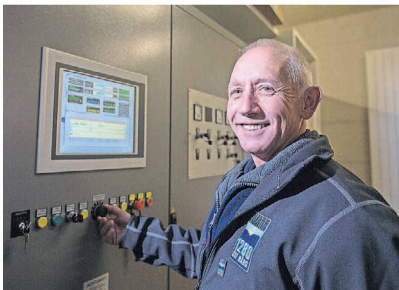
Der Seilbahn-Techniker Heinz Obi im Schaltraum der Talstation.
