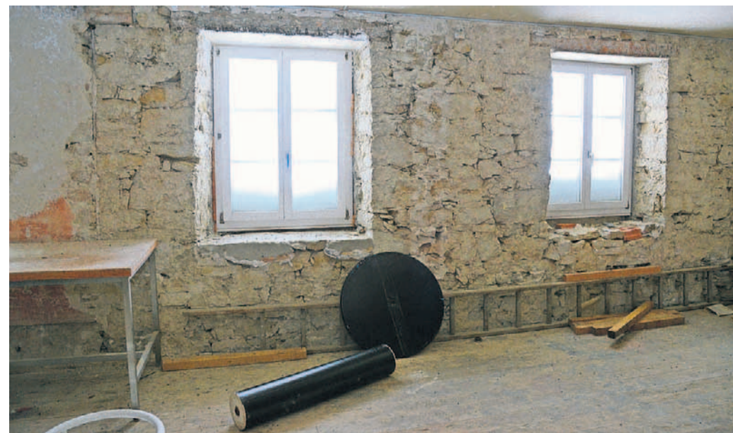
Kaum mehr als ein Rohbau: Blick in den Ostteil des Kurhauses.
