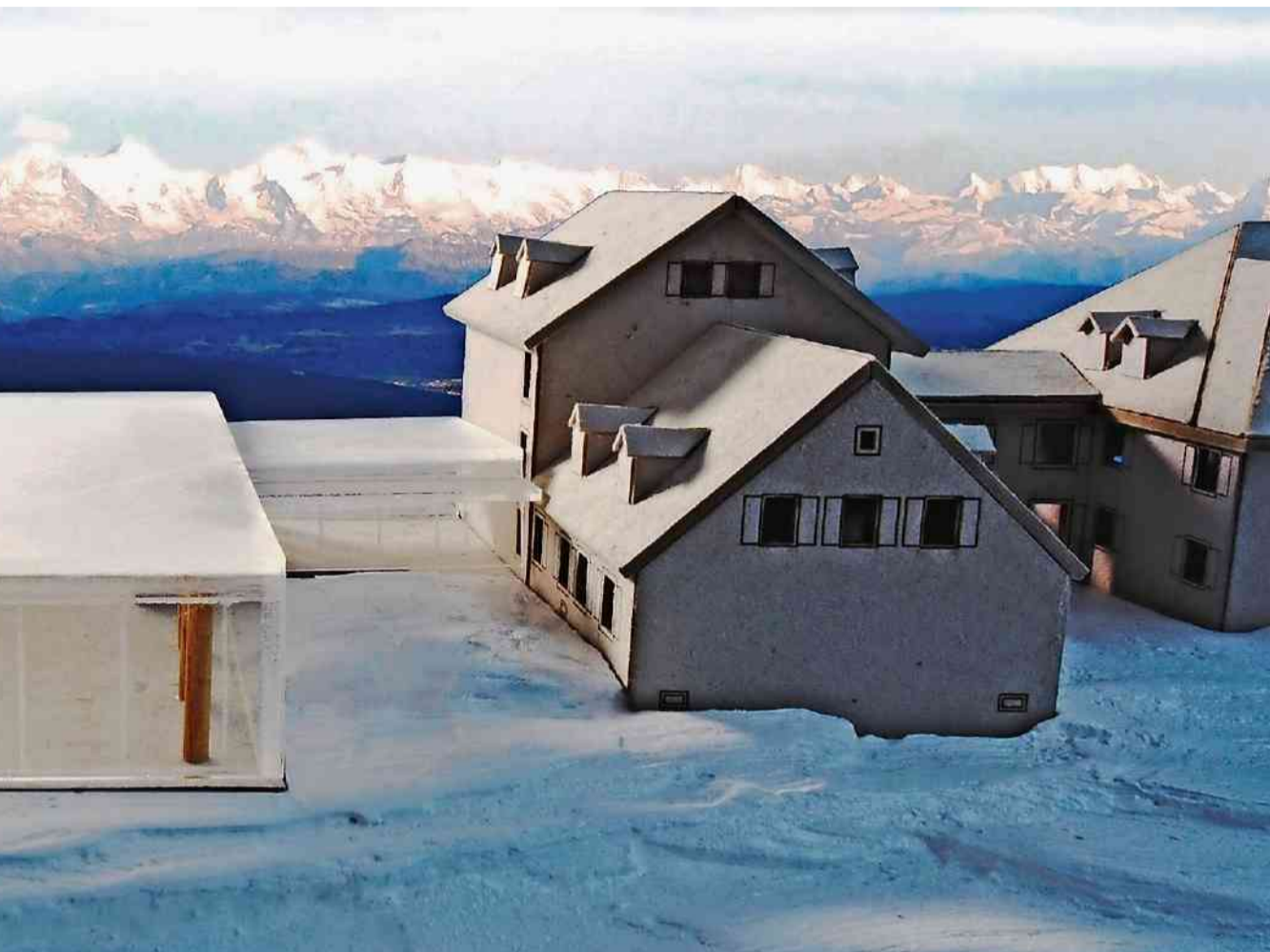
Gebäudes ein Selbstbedienungsrestaurant und einen Glaskubus für Grossanlässe anbauen.
