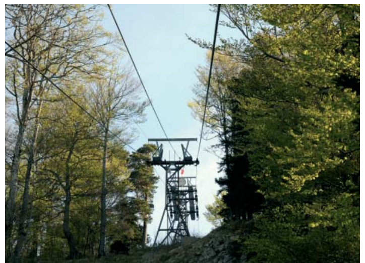
Die bestehende Bahn integriert sich in die Natur. Die neue Gondelbahn würde über sie dominieren.
